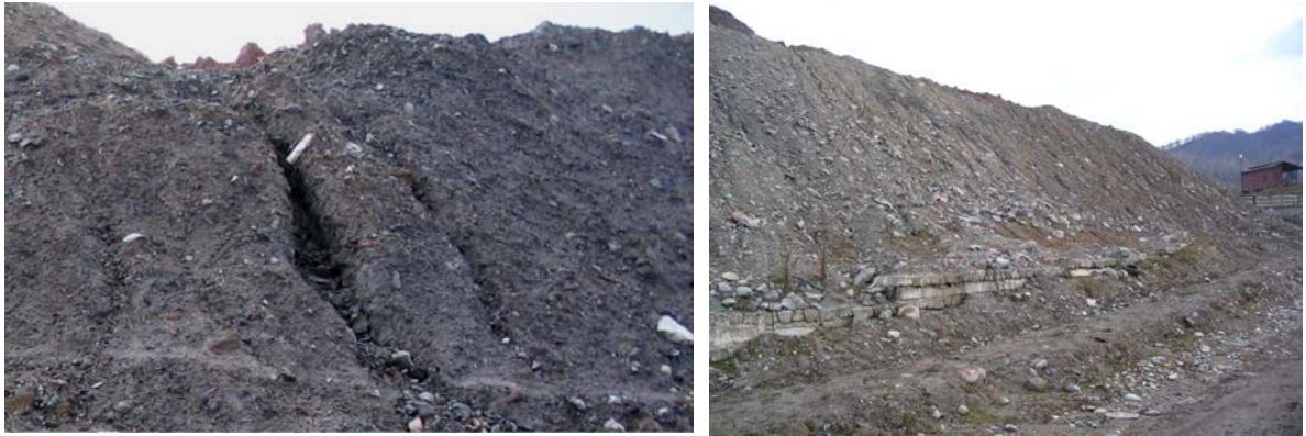
Fig. 2. Imagini- corpul de halda H 1 - eroziune in adancime /de suprafata
